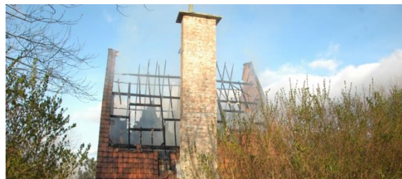
图1 捆包的固定点已经部分被烧穿。当风猛烈时，山墙就有可能倒塌。烟囱可能附着在椽子上，在这种情况下可能会损坏。 (图片来源未知)
