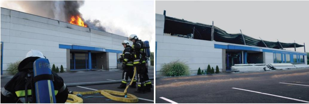
图4 由预制墙板组成的工业建筑发生火灾。因为有倒塌风险，消防员与墙体保持一定的距离。
