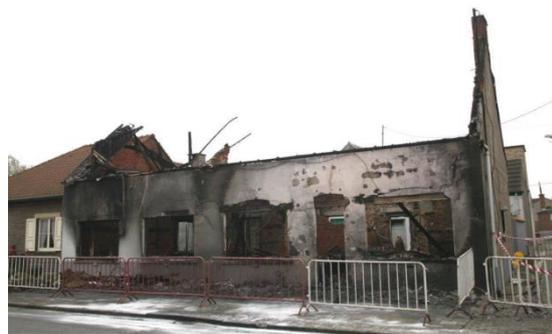
图 3 火灾后保持直立的墙体。用人群隔离栅和警戒带圈定倒塌区。（图片：来自 Herman De Wit）
