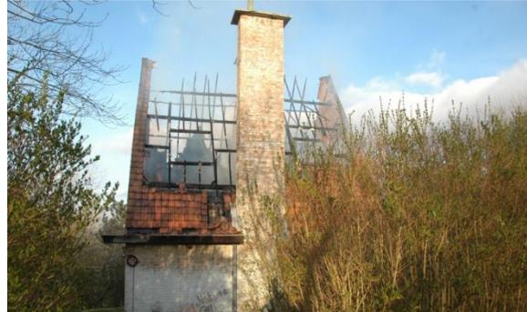
图1 捆包的固定点已经部分被烧穿。当风猛烈时，山墙就有可能倒塌。烟囱可能附着在椽子上，在这种情况下可能会损坏。
