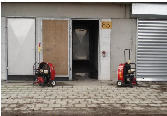
Fig. 9.8 Due ventilatori in formazione a V. Angolo di 45° (Foto: Karel Lambert)
