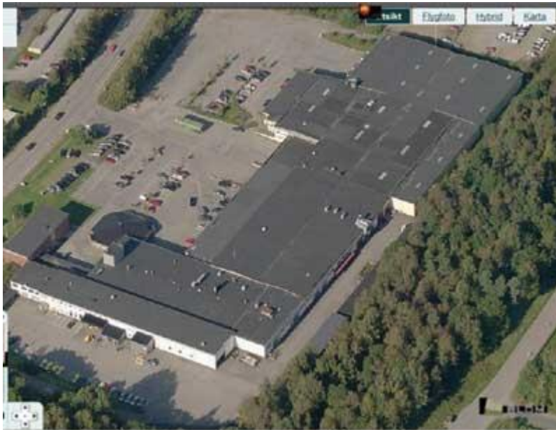
图6 一栋包括多家公司的建筑的航拍图。左边第二栋发生了严重的火灾。
