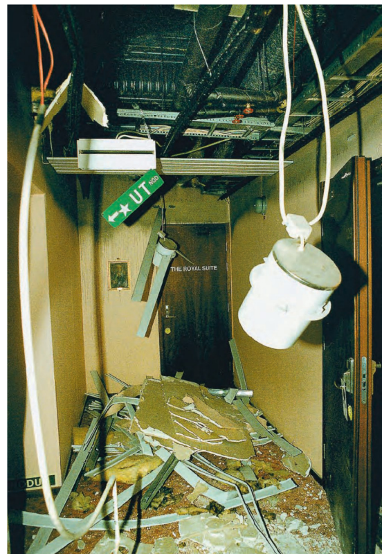
Fig 1.4 Gevolgen van een smoke explosion (Foto: Roland Stregfelt, www.msb.se )
