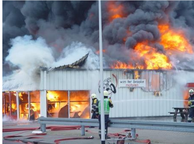
Fig 4.2 Attacco esterno ad un incendio pienamente sviluppato. La stabilità dell'edificio è compromessa e l'edificio è oltre il salvabile.
