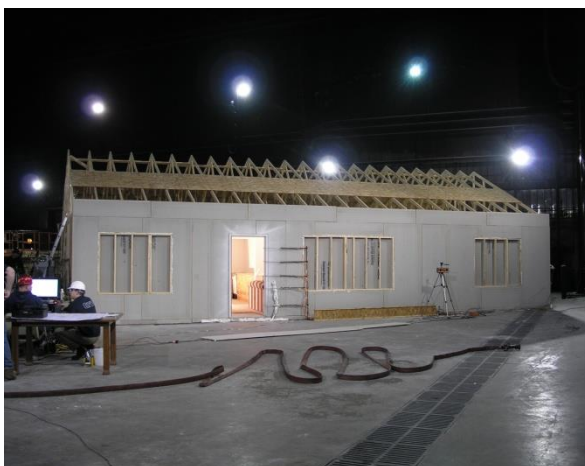
Fig 2.1 Abitazione ad un piano (112 m 2 ) (Photo: UL)
