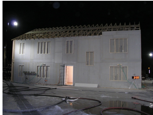
Fig. 2.2 Casa de dos plantas (297 m 2 ) (Photo: UL)
