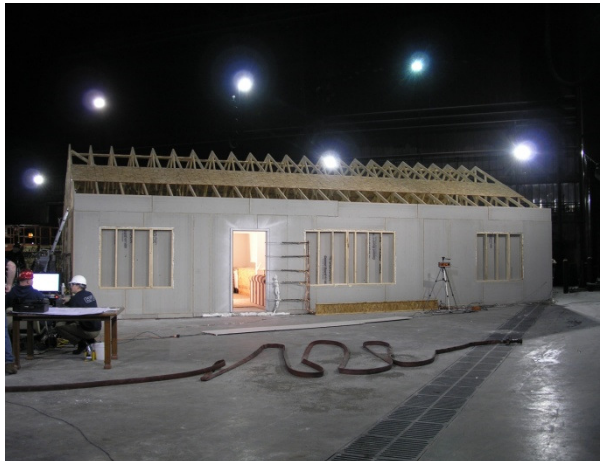
Fig. 2.1 Casa de una planta (112 m 2 ) (Photo: UL)
