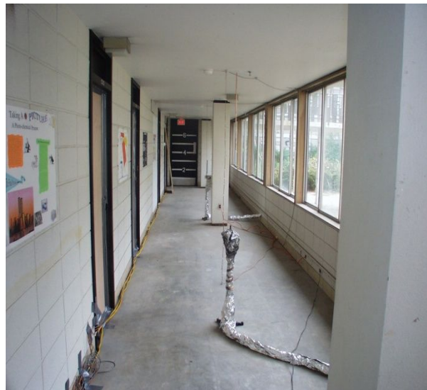
Bild 4.1 Sicht auf den Flur mit den bereits installierten Messapparaturen (Foto: NIST)
