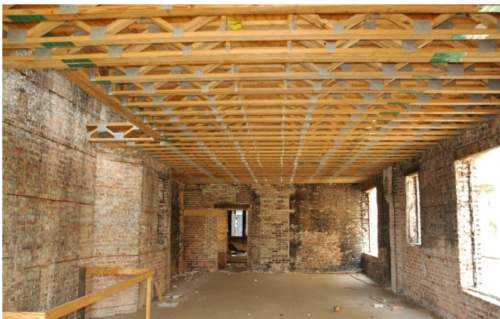
Bild 1.1 Hölzerner Fachwerkunterbau (Foto: NIST)
