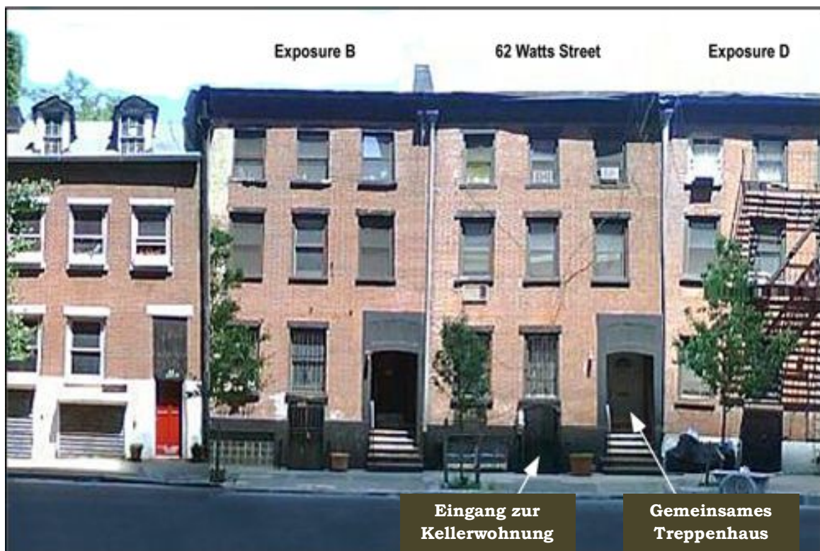
Bild 1.1 Die Fassade des Hauses 62 Watts Street. Linksseitig befand sich ein identisches Gebäude. Rechts befand sich ein ähnliches, jedoch nicht baugleiches Gebäude.
