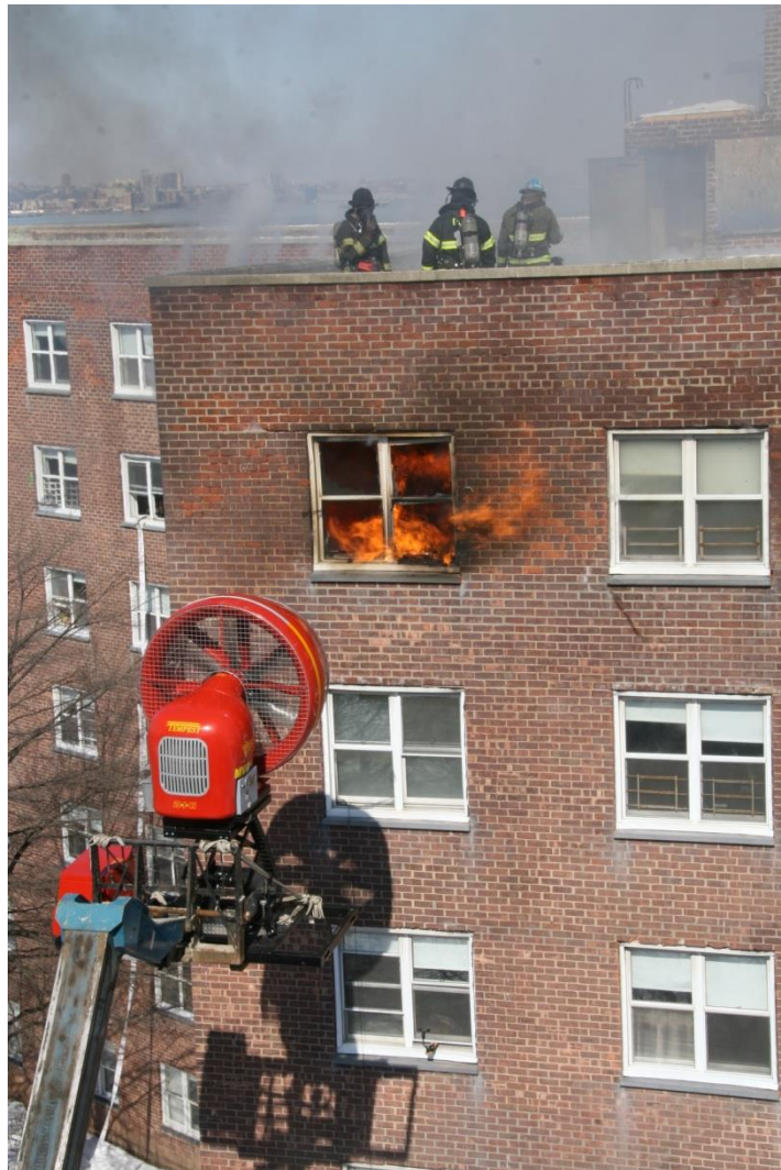
Figura 2 Evacuação assimétrica dos gases de incêndio (foto Scott Stillborn - OFS Fotógrafo)
