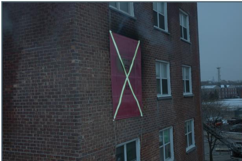
Fig 10.3 Utilizzo di un dispositivo di controllo del vento
