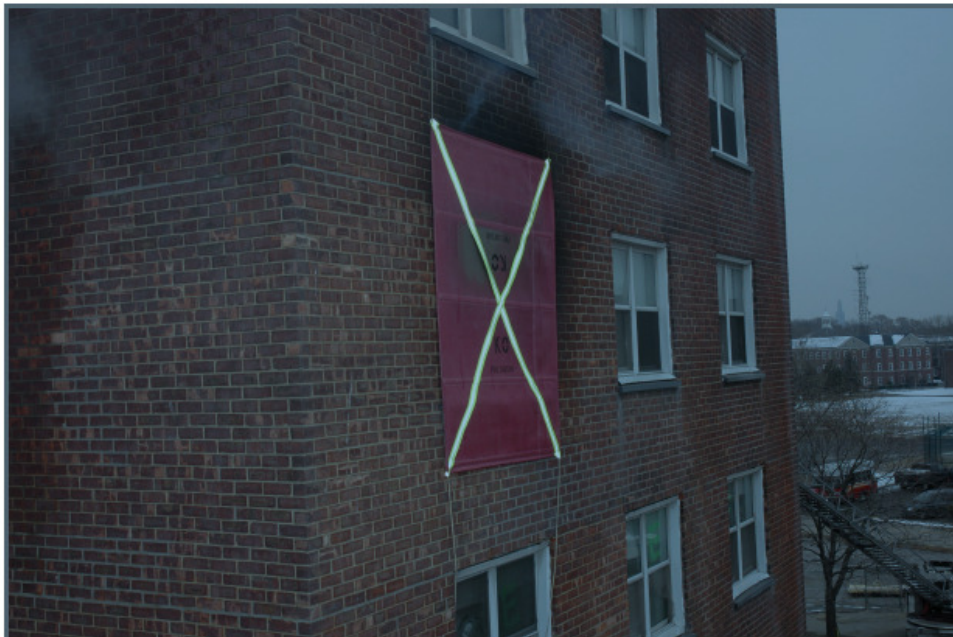
Fig 10.3 Utilisation d'un Wind Control Device (Photo : NIST)
