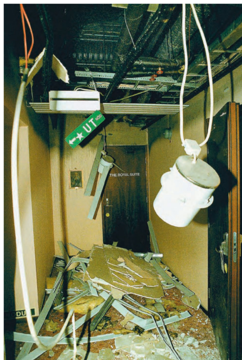
Fig 1.4 Conséquences d'une smoke explosion (Photo: Roland Stregfelt, www.msb.se )
